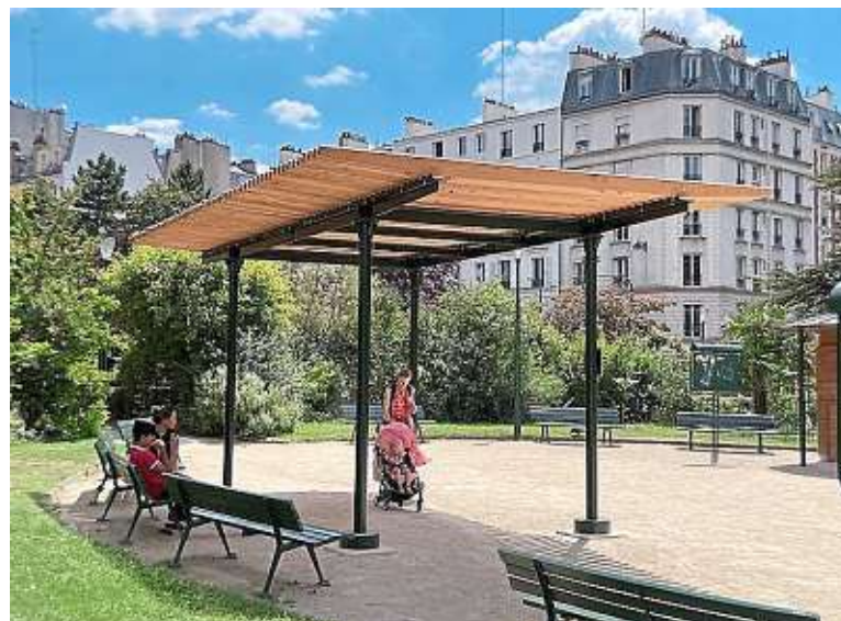
Le plan contre les canicules prévoit l'installation de 24 nouvelles ombrières. Mairie de Paris
