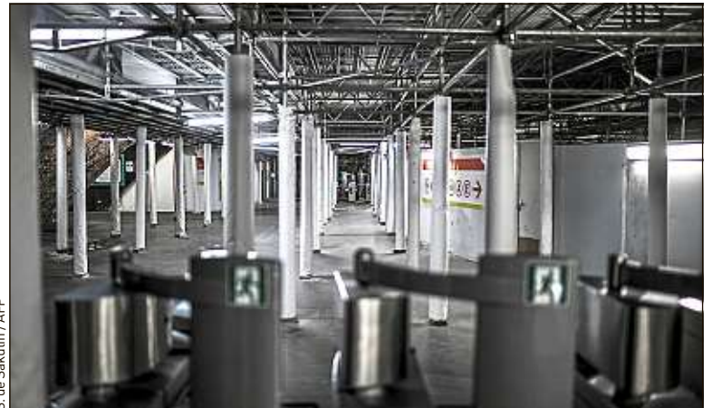
Les travaux de rénovation de la gare de RER Auber étaient à l'arrêt, en avril.
