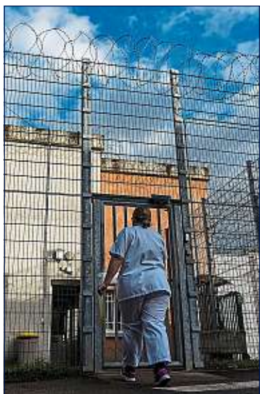
Le centre pénitentiaire de La Talaudière (Loire).
