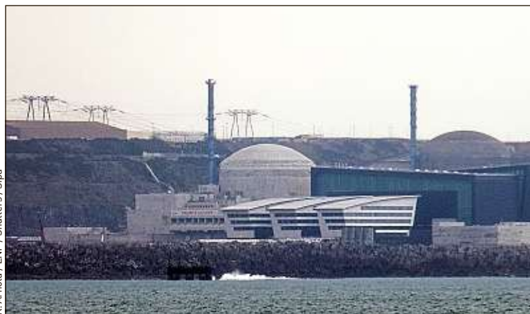
Le réacteur EPR de Flamanville est en construction depuis 2007.
