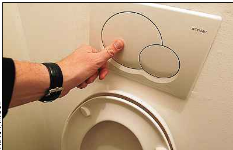
Les WC à « double touche » permettent de consommer moins d'eau.
