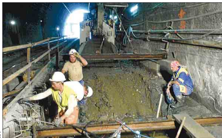
RFF a mené un chantier identique sur le tunnel de la Nerthe, à Marseille.
