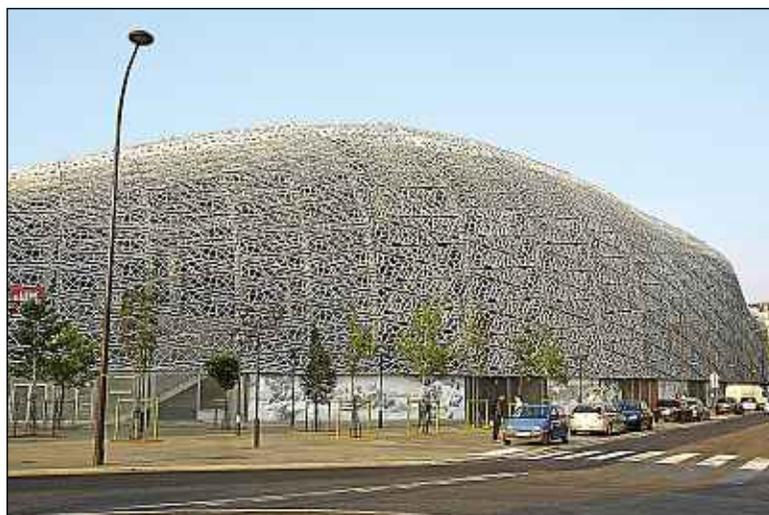
L'enceinte est recouverte d'une résille de béton fibré et de verre.
