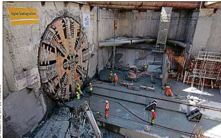
Le tunnelier a creusé 5,1 km (60% du tracé total) et redémarrera le 4 avril.
