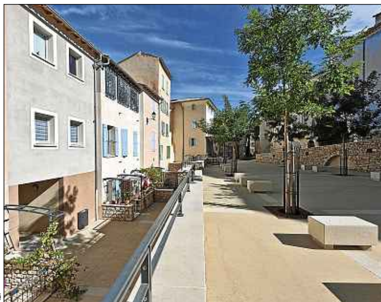
Le centre-ville de Forcalquier se paupérisait. Il a été réhabilité.
