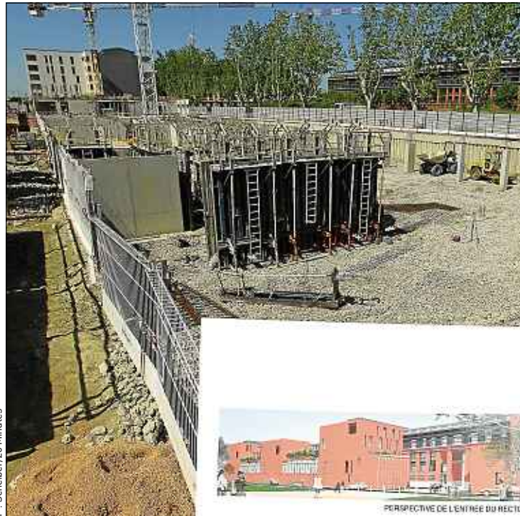
Le bâtiment de brique rose en est au stade des fondations.
