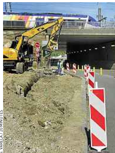
Les travaux dans la rue de Wodli.
