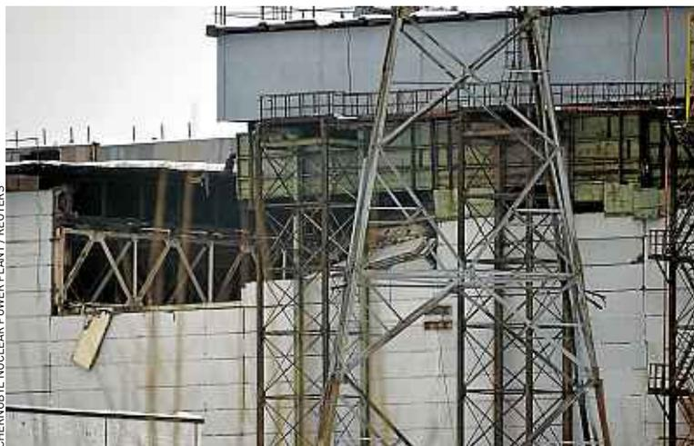
Le toit d'une salle des turbines s'est affaissé sous le poids de la neige.
