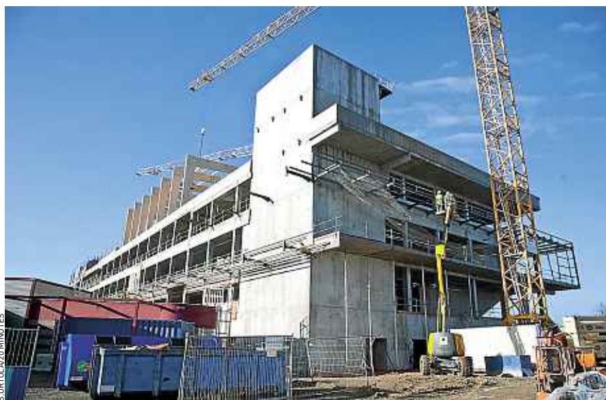
La fin des travaux sur ce nouveau bâtiment est prévue pour juin 2013.
