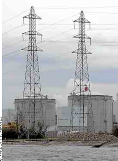
La centrale est la plus vieille de France.
