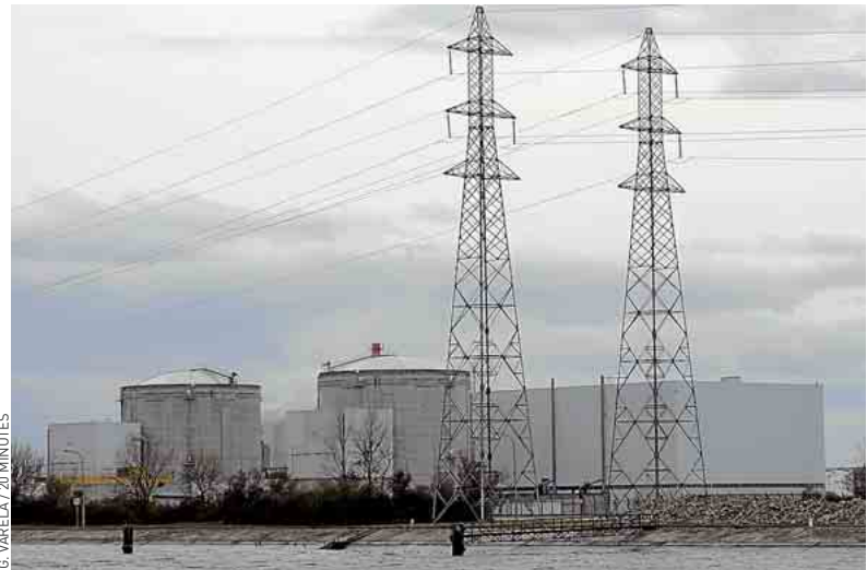
Une cinquantaine de pompiers seraient intervenus à la centrale de Fessenheim.
