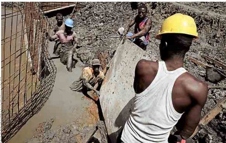
A Kafarande (Guinée), la construction d'une écluse a été financée par l'AFD.
