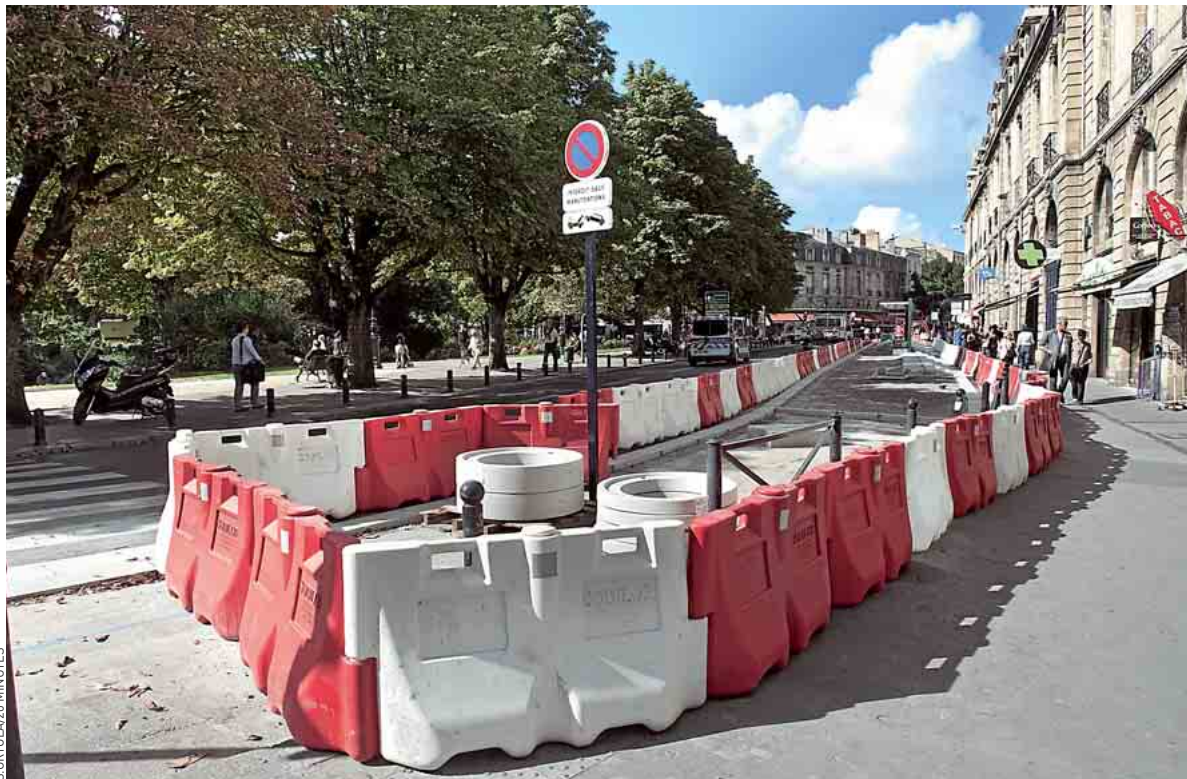
L'élargissement des trottoirs permettra une meilleure cohabitation entre bus et piétons autour de la place Gambetta.
