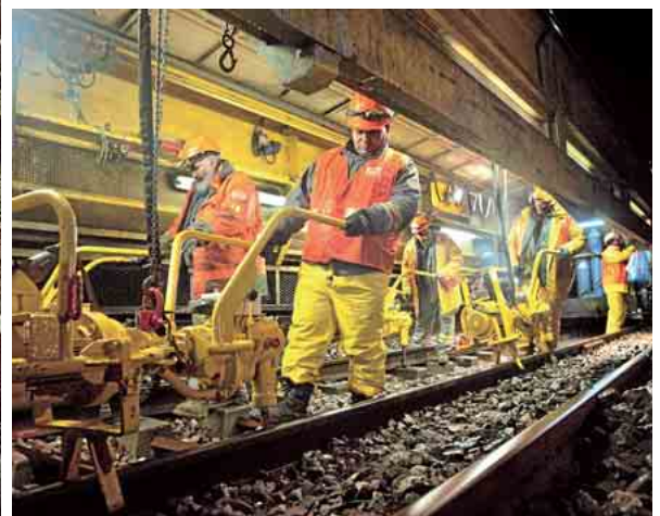
Les deux « trains de suite » de 700 mètres de long permettent le changement du ballast et le remplacement des rails.
