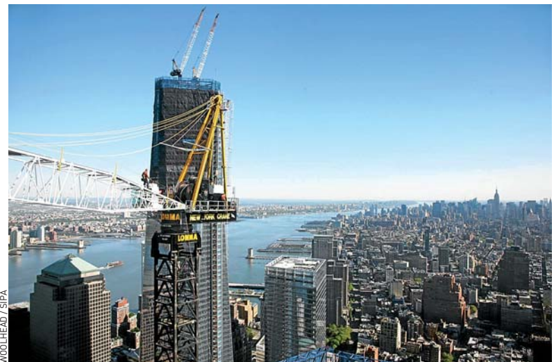
Une fois achevée, la tour WTC culminera à 541 m de hauteur.
