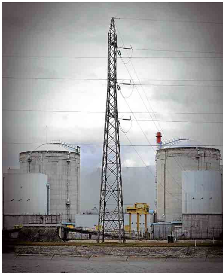
Doyenne du parc français, la centrale de Fessenheim est exploitée depuis 1977.
