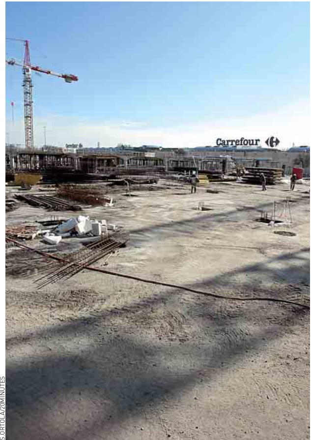
Les travaux du parking ont déjà commencé.
